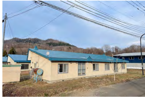
改修工事を実施しなかった金山町有住宅
