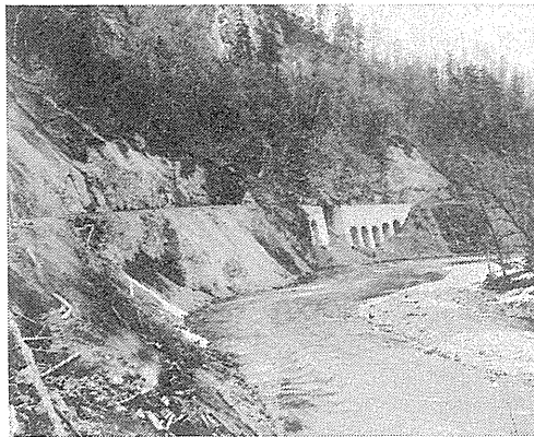
鉄道十勝線金山隧道付近—明治34年（佐藤清二蔵）
