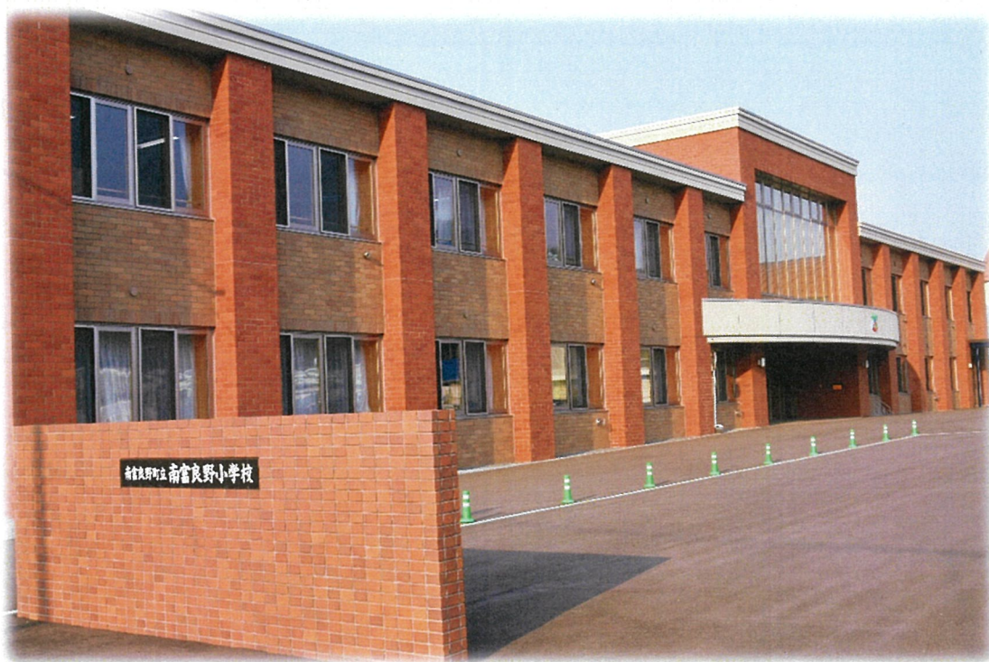
南富良野町立南富良野小学校
