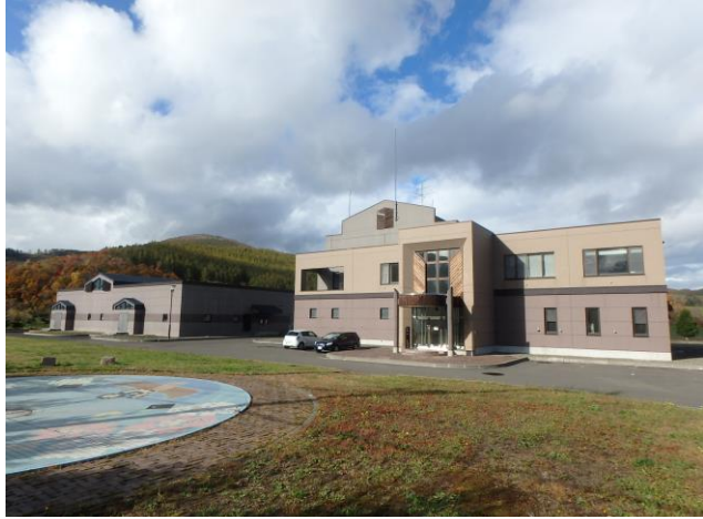
南富良野浄化センター
