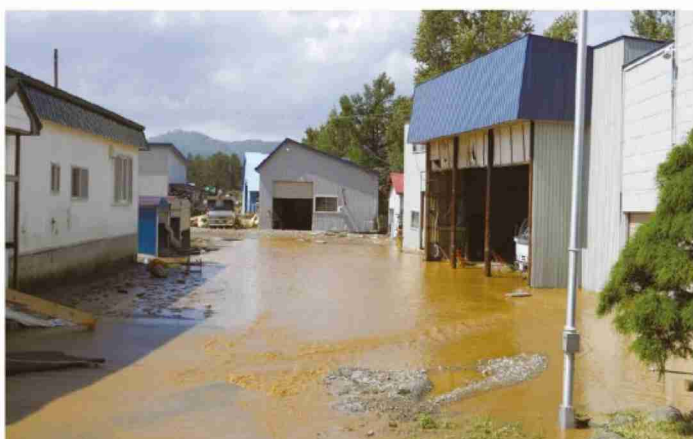
輸送部門の南富サポートもトラック3台、タイヤショベル2台が輸送不能となる被害に遭いました。
