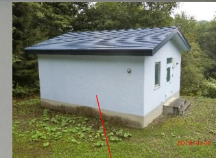
貯留タンク (浄水を貯蔵する装置)
