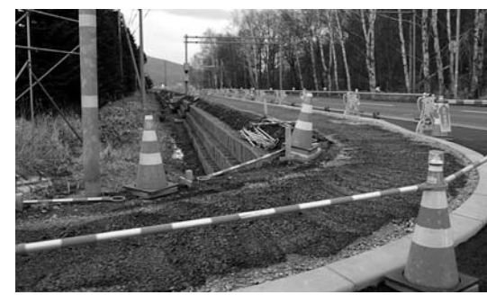
国道38号歩道改良工事
