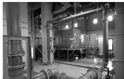
町浄化センター内部
