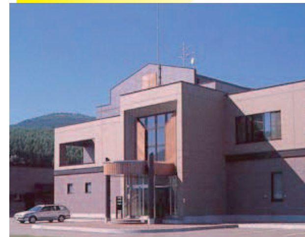
南富良野浄化センター
