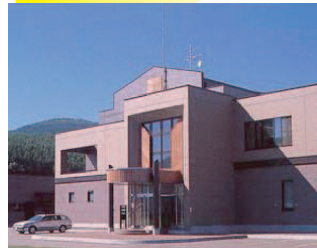
南富良野浄化センター
